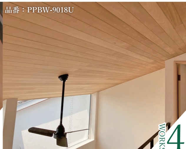
施工時期/2020年6月 現場住所/愛知県常滑市(住宅) 商品名/サーモバスウッドパネリング
